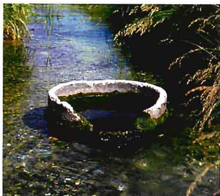
Foto 2.3: tino in cemento con il bordo superiore rotto sul lato verso valle per favorire il deflusso dell'acqua (fontanile il Guado, Pandino).
