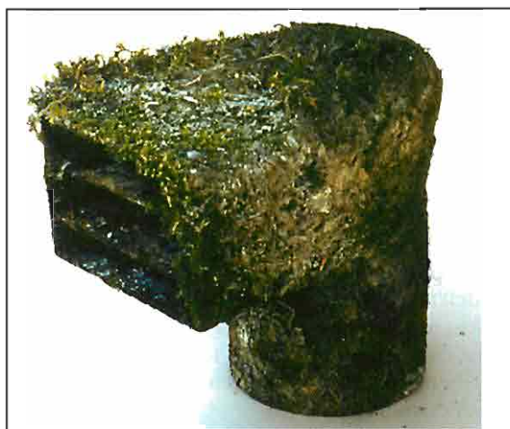
Foto 1.2: particolare dell’estremità di un tubo, sagomata a “L” (per meglio indirizzare il flusso d’acqua) e dotata di un’apertura a grata per ridurre i rischi di occlusione.
