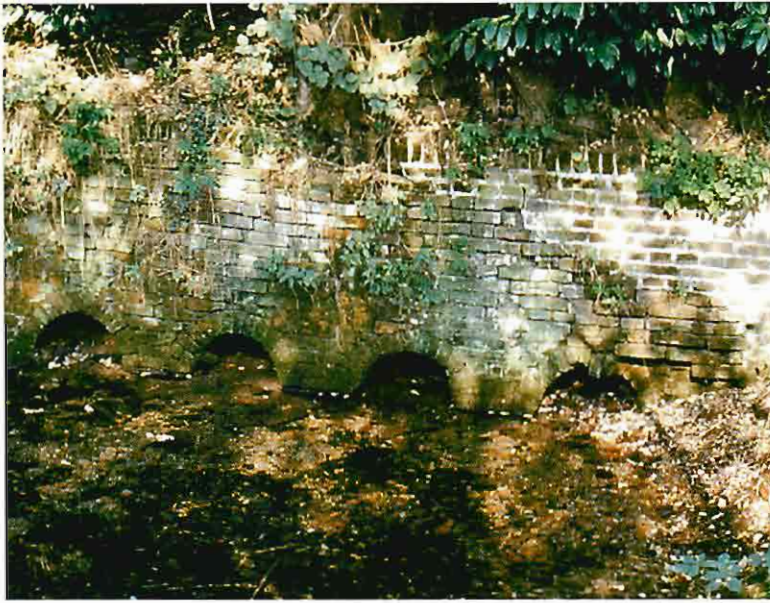
Foto 2.5: muro in mattoni fenestrato (fontanile Acqua Lama, Soncino).
