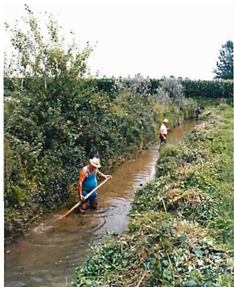
Foto 3.5: fontanile Morgola (Sergnano 16 luglio 1998), lavori di ripulitura dell'alveo.
