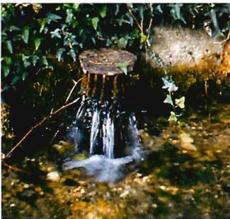
Foto 2.1: tuba con “cappellotto” terminale fenestrato (fontanile Seriola, Soncino).
